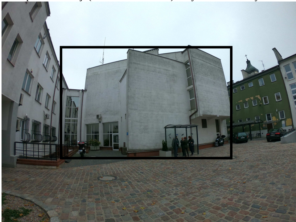
B. docieplenie elewacji z elementami architektonicznymi budynku C od strony dziedzińca i od strony północno zachodniej
