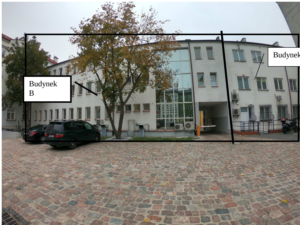
-docieplenie elewacji (część rozbudowana ) budynku A od strony dziedzińca
