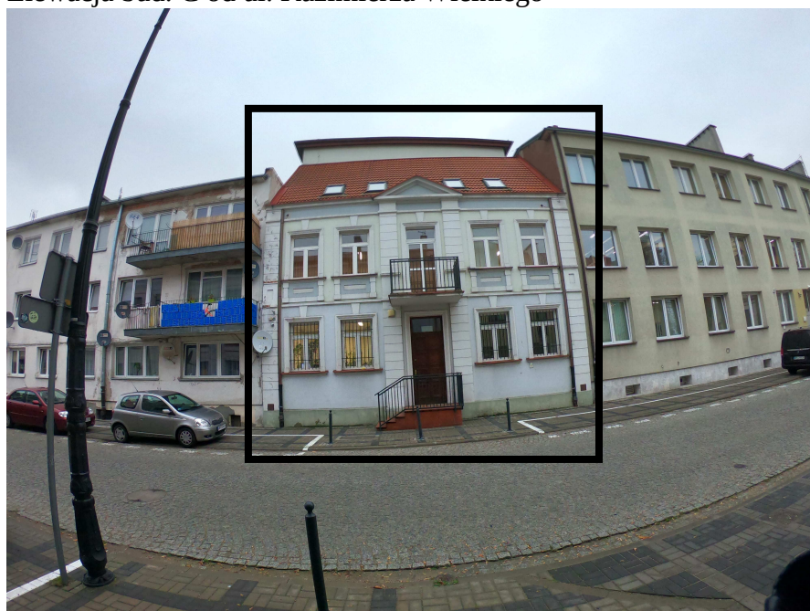
Elewacja bud. C od ul. Kazimierza Wielkiego
