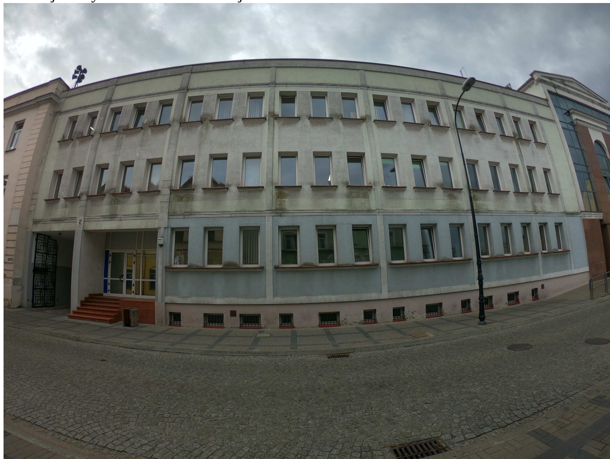
Elewacja budynku B od ul Zduńskiej
